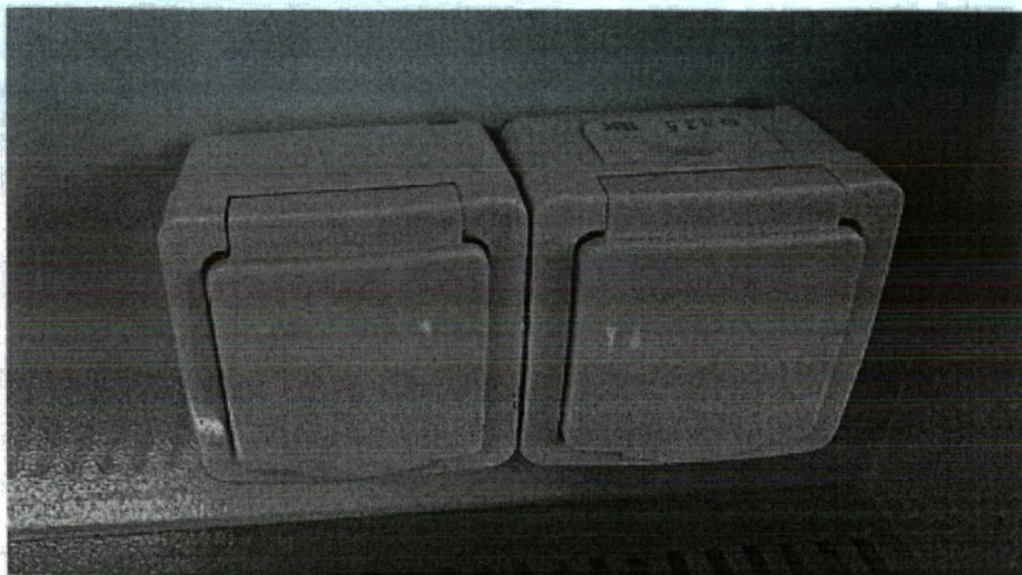
Розетки без маркировки
